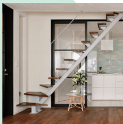
角パイプ・本桁階段(3段曲)
