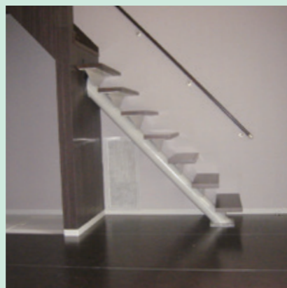
丸パイプ一本桁階段
