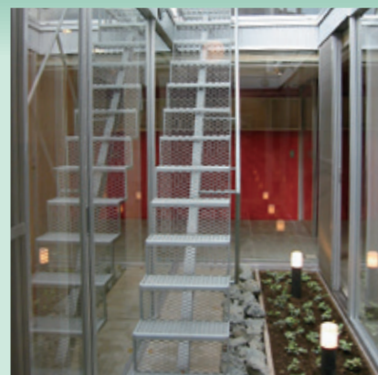
H鋼一本桁階段
