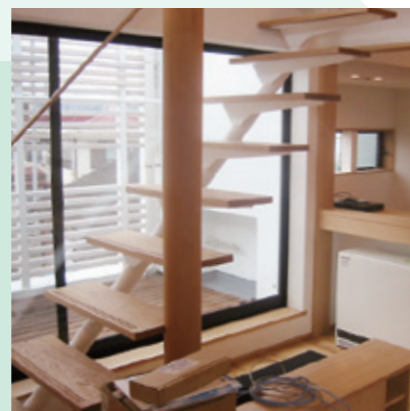
丸パイプ一本桁片寄せ階段
